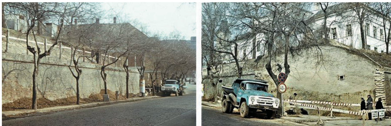
2. kép. 1: Téglá támfal a „Várhegy” déli oldalán; 2: A támfal felújítás alatt lévő délkeleti sarka
